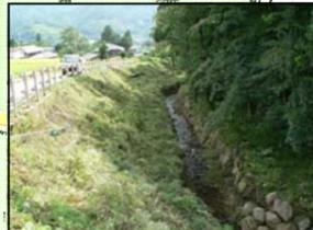
水路はコンクリートを使わず、町内の工事で出た転石を利用して「生き物に優しい」石積みです。
