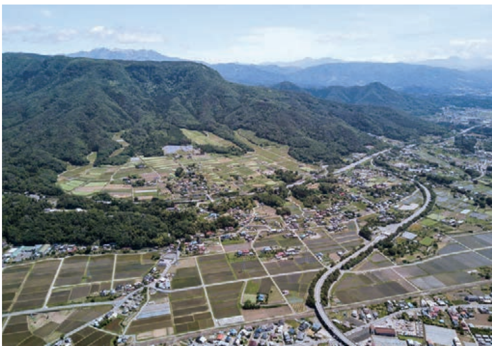
▲月夜野インターチェンジ付近
