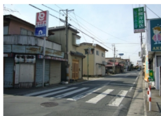
③歩道のない道路に面する住宅
