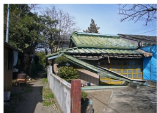
①老朽化した空き家
