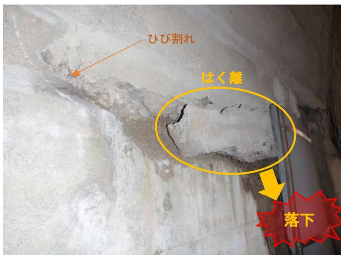
写真-3. 側壁部のはく離
