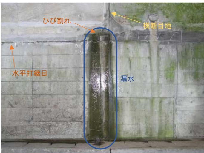
写真-4. 横断目地及びクラックからの漏水
