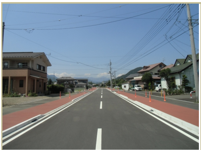
5. 本線縦断ルート中間部付近より北側方向
