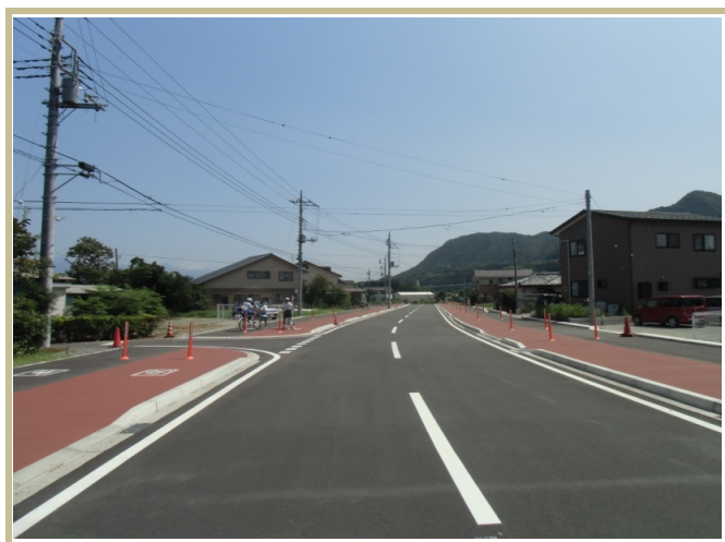
6. 本線縦断ルート中間部付近より南側方向
