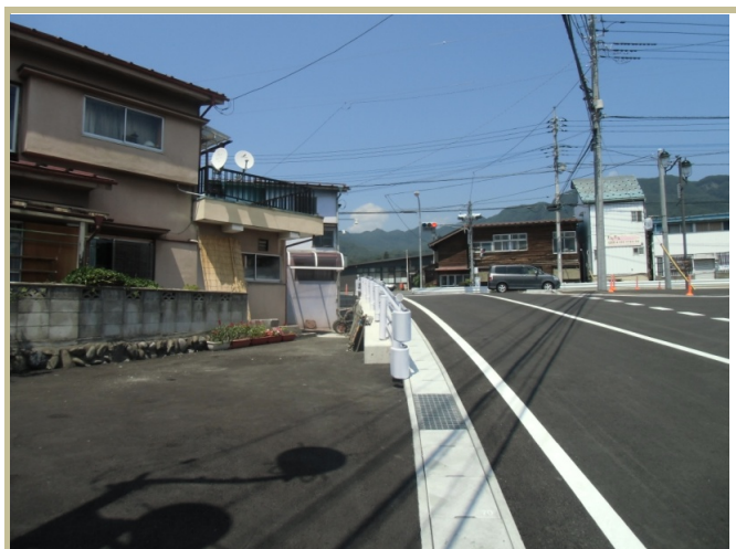
3. 登り方向左側沿道宅地との高低差のようす
