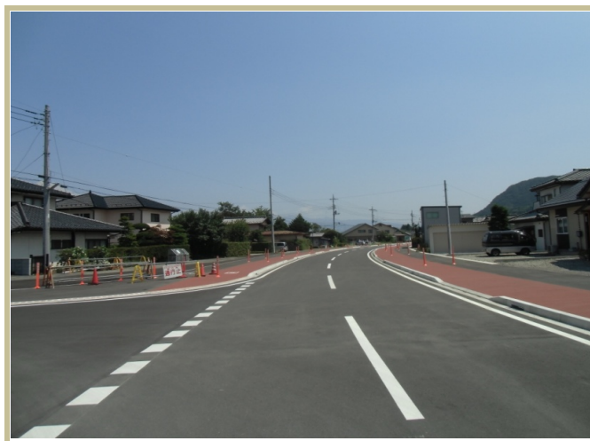
4. 後閑駅坂線交差部より南側方向
