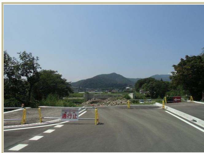
2. 真政・悪戸線利根川左岸終点
