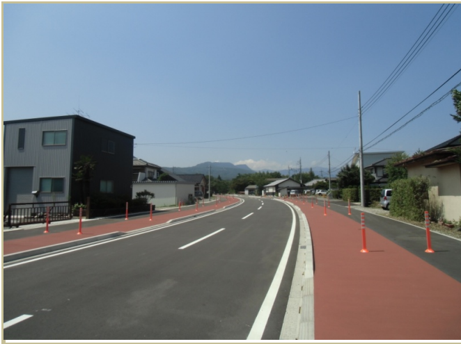
7. 本線縦断ルート中間部付近より北側方向
