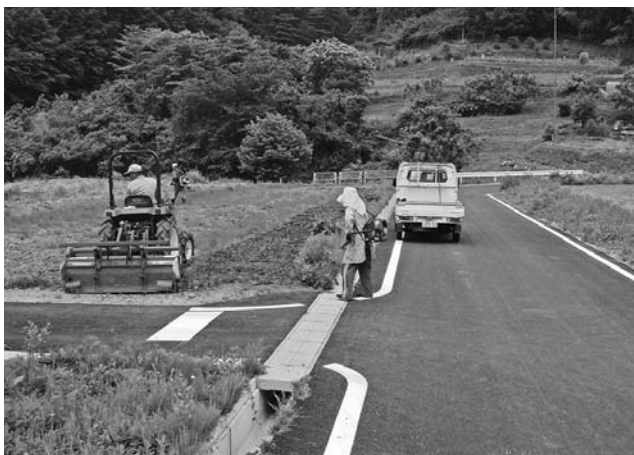
▶完成した穴切地区農道
