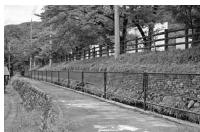
写真=用水路沿いのフェンス整備が行われた4ヶ村用水
