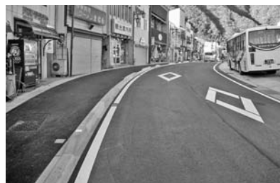
写真=無散水消雪設備や歩道を新設しました (JR水上駅前)
