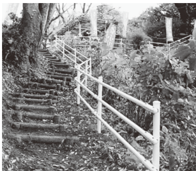
◀完成した手すり
