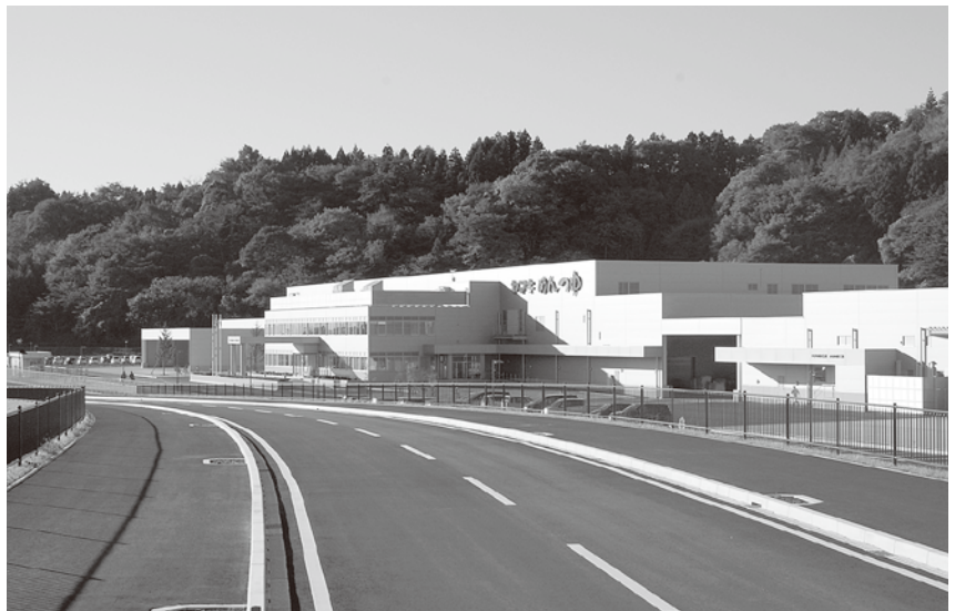
▲竣工を迎えたヤマキみなかみ工場
