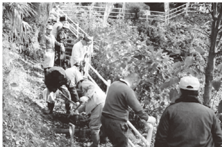
▶手すりの設置作業
