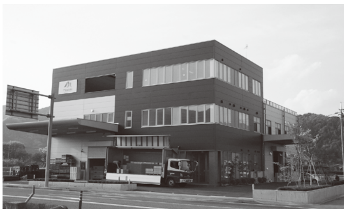
▶完成した上津の新工場
