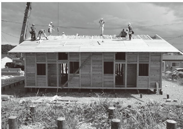
▲屋根用断熱材として茅を使用した被災者用仮設住宅建設の様子(写真提供：上野さん)
