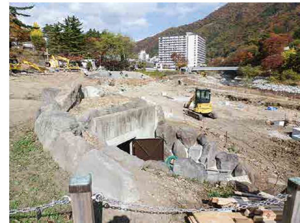
かわまち事業により改修が進む親水公園
