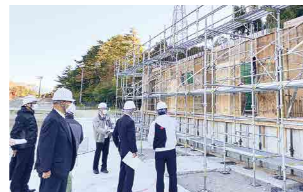
新たに開校する水上小学校のプール建設工事
