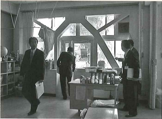
扉の使用が可能となるよう施工された鉄骨ブレース
