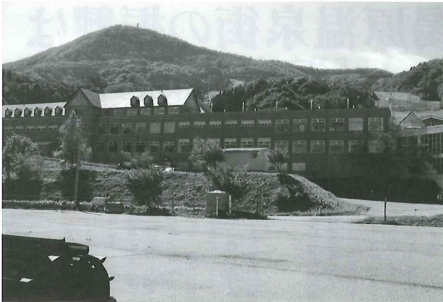
ノルン水上スキー場の管理棟
