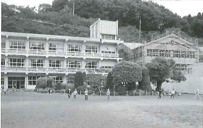
JVにより建設されている統合小学校
