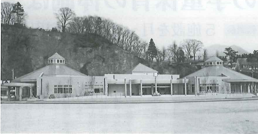
内部の施設についていくつかの変更が行われた
