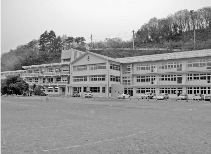
現校舎の解体と新校舎の建設が並行で進んでいる
