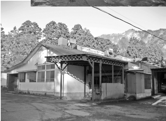
建設から 40 年を越えた水上給食センター
