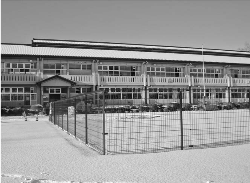
旧須川小学校舎の改装により整備が進む
