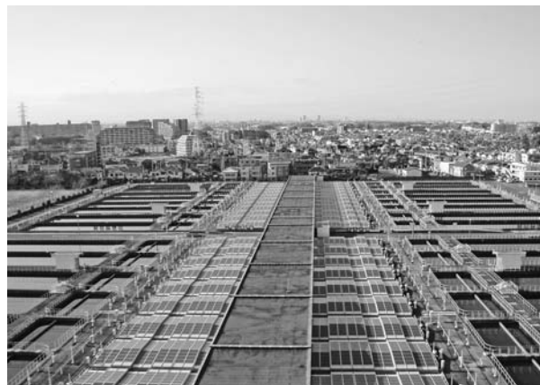
浄水場全景 細かい格子状のパネルは太陽電池
