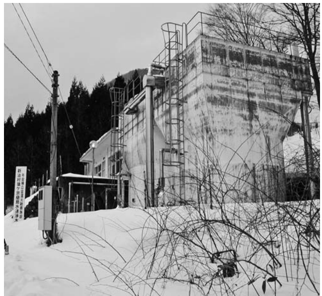
猿ヶ京簡易水道浄水施設
