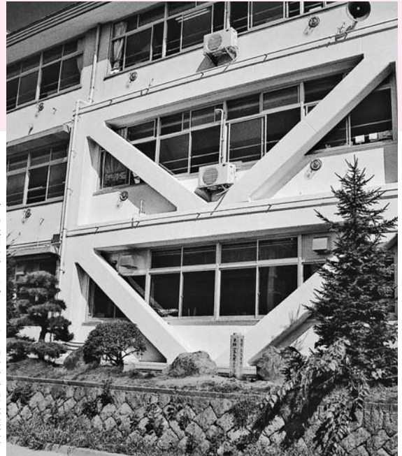
耐震補強を施した古馬牧小学校校舎 (二点とも)
