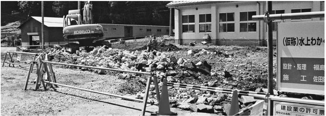
(仮称) 水上わかくりこども園施工現場
