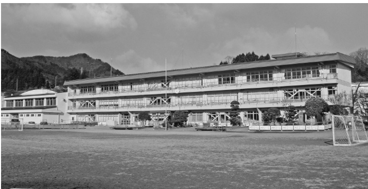
耐震補強工事が計画よりも前倒して事業実施された（桃野小学校）
