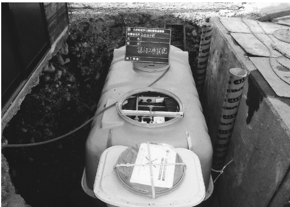
合併浄化槽の掘付工事
