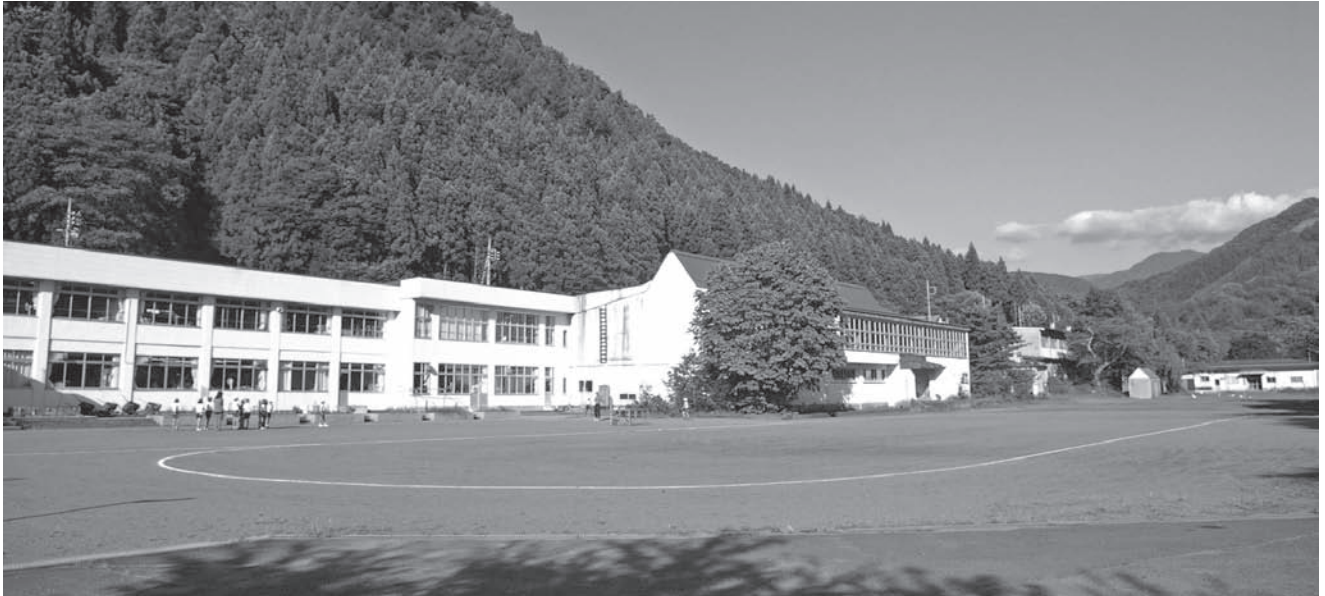
統合により役目を終える幸知小学校校舎（左手前）と第二保育園園舎
