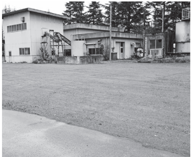
解体が実施された箇所の様子
