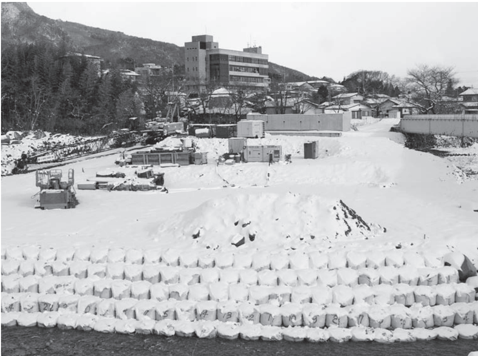
真政悪戸線の橋梁部工事
