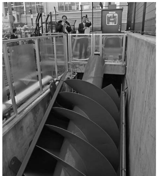
建設中の小水力発電所「元気くん3号」
