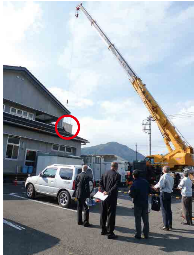
新治学校給食センター。クレーンの先に吊されているのが新しい空調設備です。
