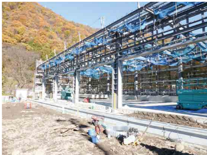
除雪機械格納庫。今までは除雪機械を出勤させる前に、まず機械の上に降り積もった雪落しが必要でした。格納庫が完成すれば迅速に作業が開始できます。
