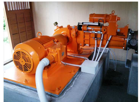
▲矢瀬親水公園内で稼働する小水力発電設備
