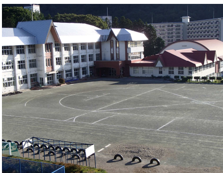
▲水上小学校グラウンド整備
