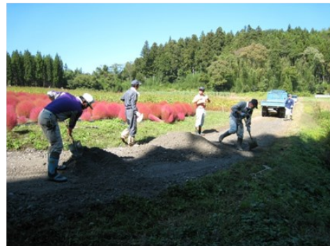
↑ 碎石の敷設作業の様子
