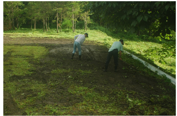
← 駐車場の整地作業
