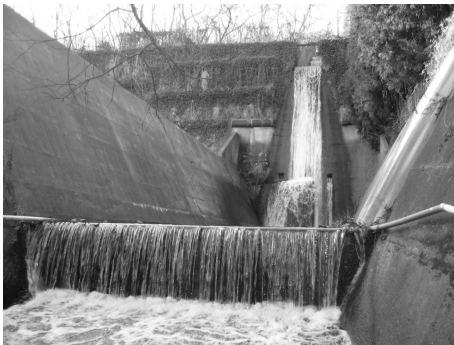
▲小水力発電が設置される矢瀬地区の水路
