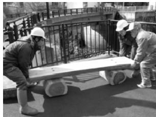
▲遊歩道へのベンチの設置作業
