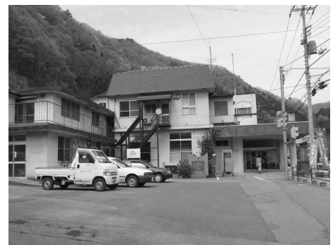
▲老朽化が進む水上支所(奥)と駐車場(手前)
