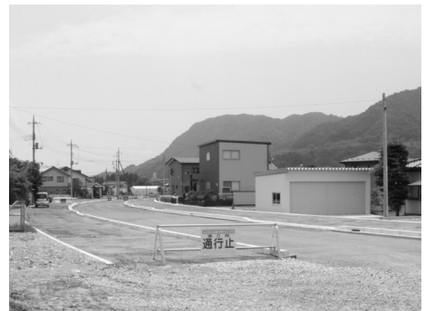
▲建設中の真政悪戸線
