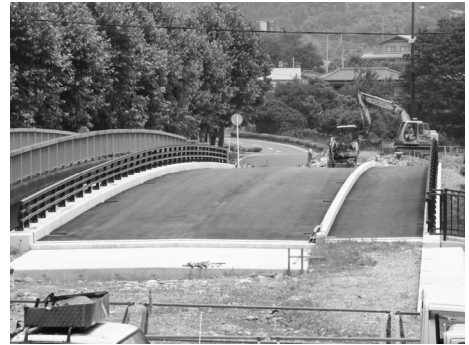
▲上部工が完了した悪戸関口線の関口橋
