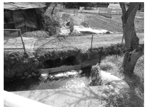
▲整備が予定されている松葉沢排水路
