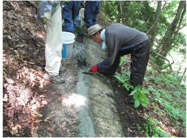
現地に資材を運びコンクリを練って歩道の補修
