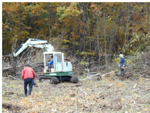
←重機等による作業
