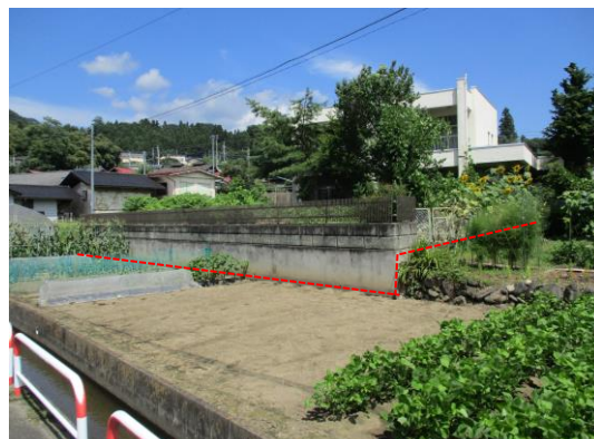
写真④ 南東方向から撮影
