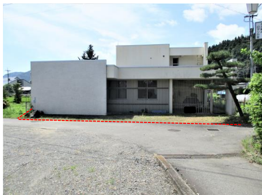
写真① 北方向から撮影
