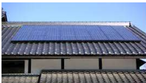
太陽光発電設備
