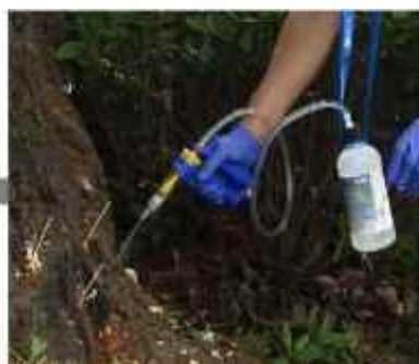
専用の注入器で薬剤を注入
