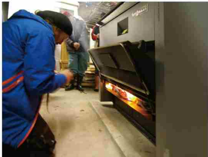
図 導入された新ボイラー 図 薪ストーブ 新ボイラー・薪ストーブの補助事業を通して、既存の化石燃料から木質バイオマス燃料へのエネルギー転換を行い、燃料コストと二酸化炭素排出量の削減を実現するとともに、派生する雇用の創出と資金の地域内循環による地域振興を目指しています。
