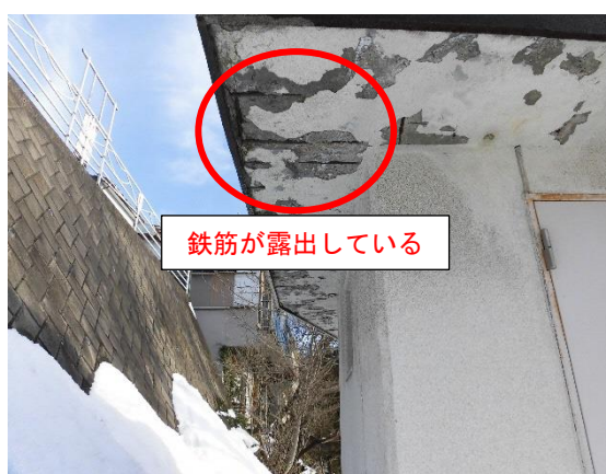
小日向ポンプ場
