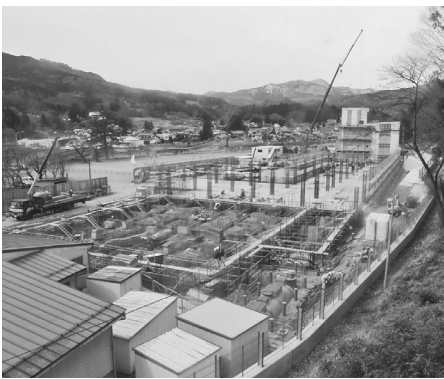
建設が進む(仮)新治統合小学校
