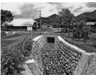
写真=後閑地内の松葉沢工区に整備された排水路
