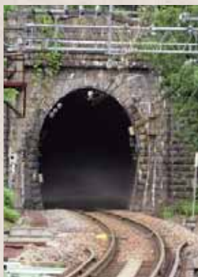
▲清水トンネル
