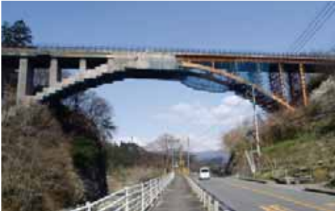
▲橋梁補修工事の様子
