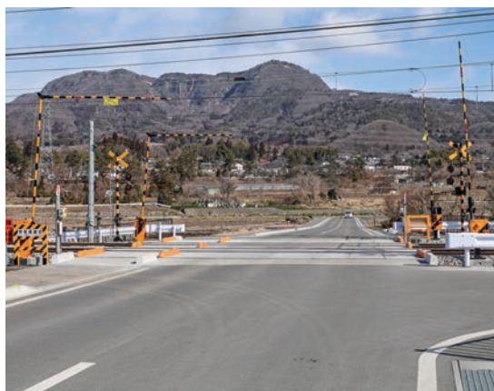
▲完成した学校裏踏切
