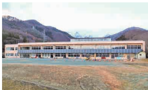
▲現在工事中の水上小学校(旧水上中学校)
