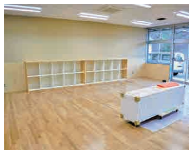
▲改修中の教室
