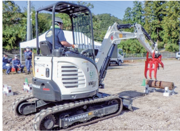
▲実践講習会(解体)
