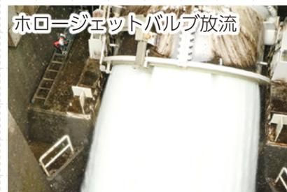
毎秒100トンの水を放流できる国内最大級、直径2.4mの大型バルブ。来場者は圧倒的水圧と轟音を間近で体感しました。
