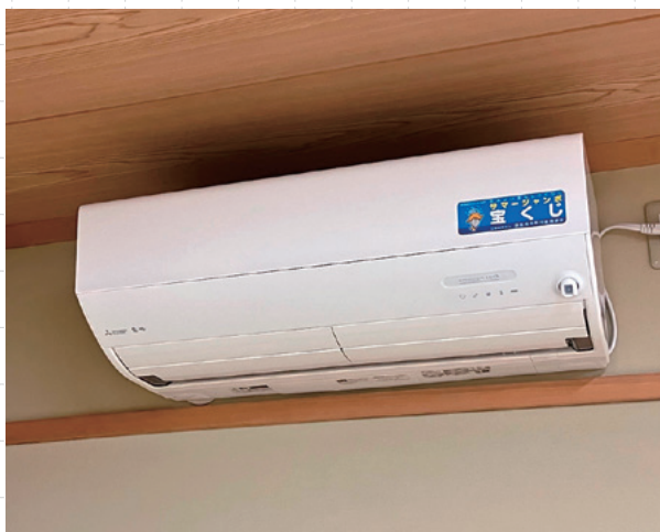
▲整備されたエアコン
