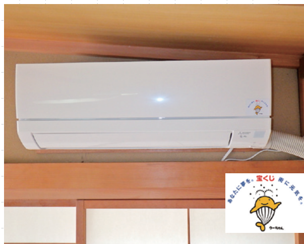
▲整備されたエアコン
