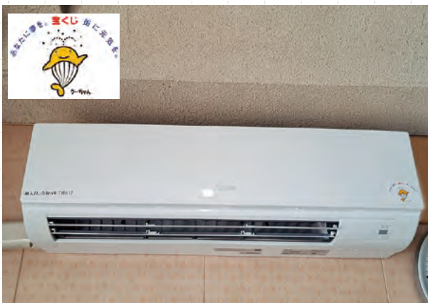
▲整備されたエアコン
