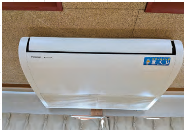
▲整備されたエアコン
