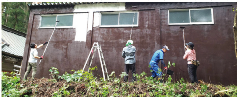
▲公共建造物の塗装作業
