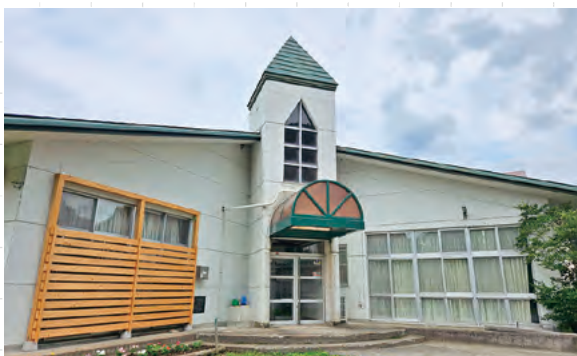
▲こどもの居場所「みなくる」の外観(旧水上児童館)
