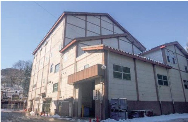
▲固形燃料化施設
