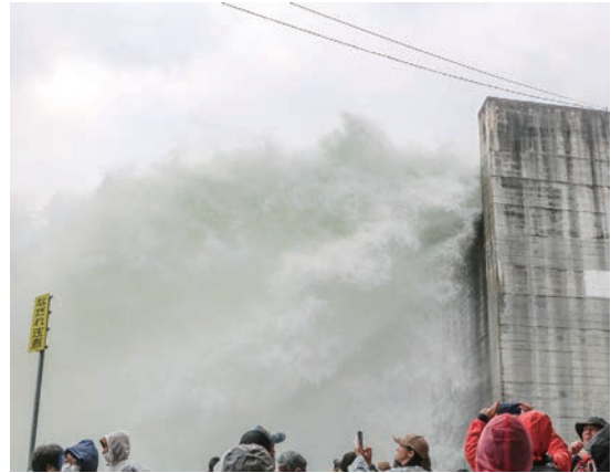
▲矢木沢ダム点検放流
