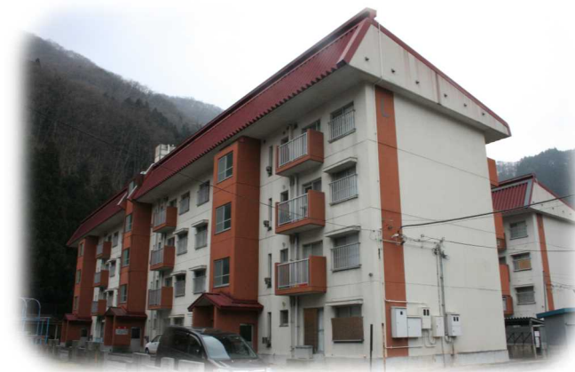
改修予定の町営住宅鹿野沢団地 (町営住宅リノベーション推進事業)
