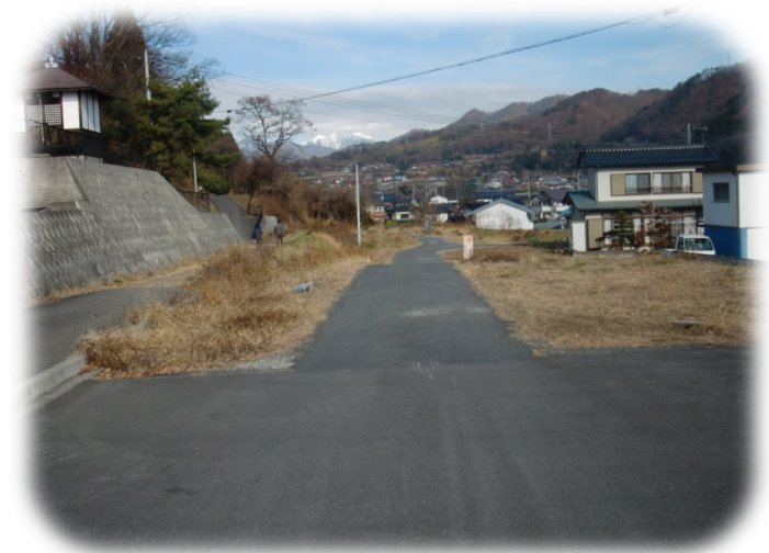
整備予定の町道悪戸矢瀬線
